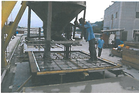
(c) 실험체 슬래브 타설
