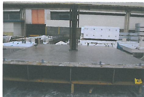
(d) 슬래브 타설 완료
